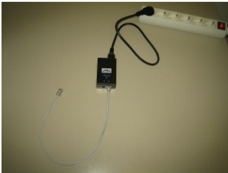
Figura 5.2- Segon pas de l'engegada d'un node qmk : connexió d'un dels extrems d'un cable de xarxa la sortida POE del transformador.
